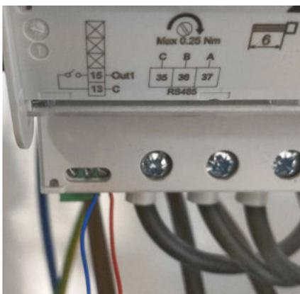
Anschluss am LG Wechselrichter
