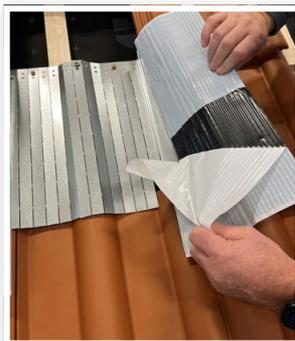
Klebefolie rechts abziehen, auf Grundträger und Dachziegel vollflächig andrücken. Untergrund muss trocken, staub- und fettfrei sein, Temperatur min. +5° C.
