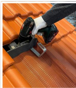
Dachhaken verschrauben und oberen Überstand der Ziegelerersatzplatte 10 mm hochstellen.
