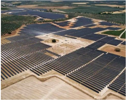
Spanien Versorgungsausmaß 175 MW
