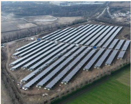
Italien Versorgungsausmaß 8,2 MW
