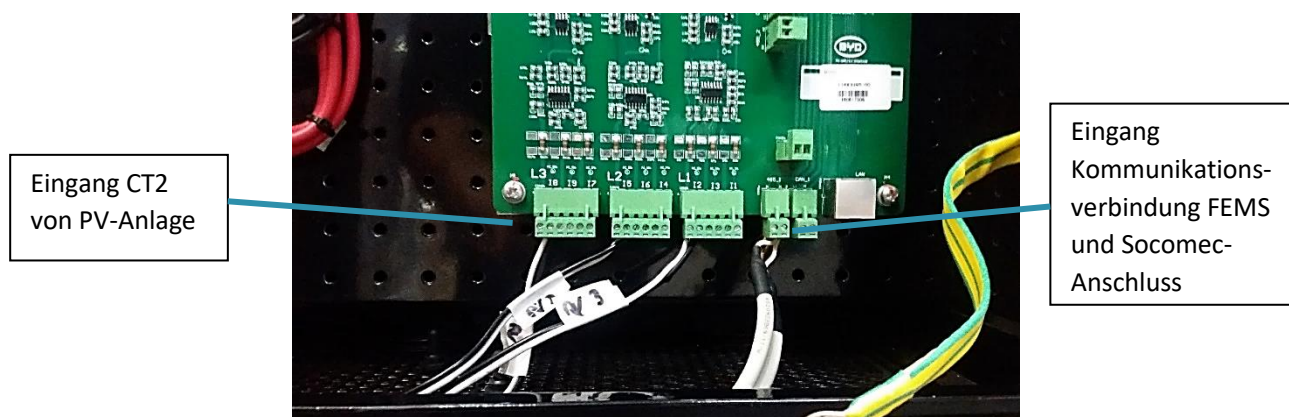
Abbildung 16: Anschluss 3 Phasige PV
