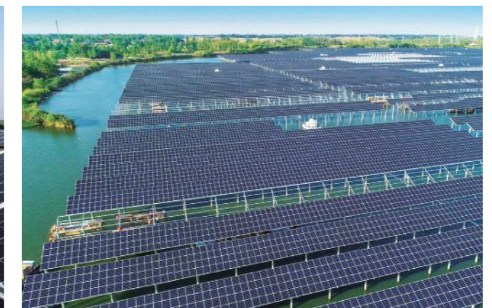
DAS DRITTE TOP-RUNNER-PROJEKT IN SIHONG, JIANGSU, CHINA (CHINA) 170MWp Modultyp: LR6-60HBD 315Wp Fertigstellung: Okt. 2018
