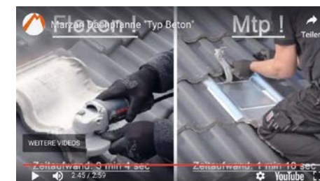
Zeitersparnis durch Einbau unserer Metaldachplatte
