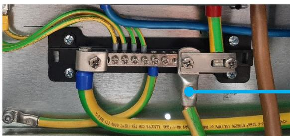
ABBILDUNG 23: FUNDAMENTERDER ANSCHLIEßEN
