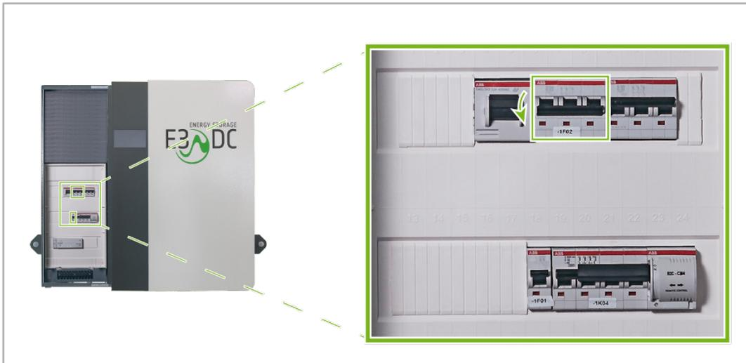
Abb. 164: LS-Automat für den E3/DC-Wechselrichter ausschalten (1F02)
